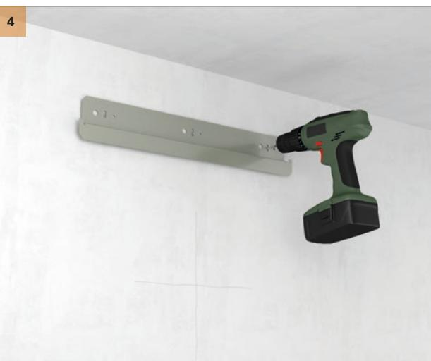
Просверлите отверстия и установите кронштейн для установки.
