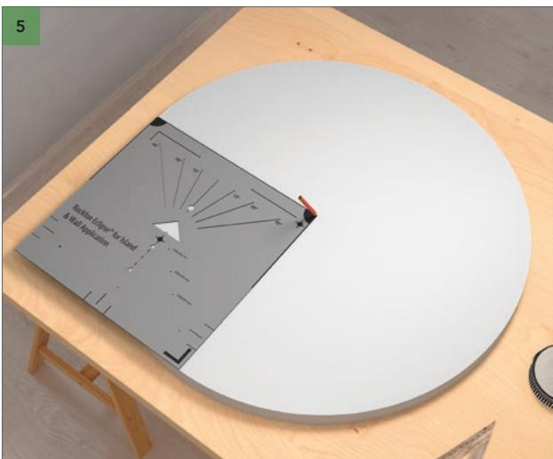
Расположите шаблон так, чтобы верхний левый и правый нижние углы находились на касательной круга на задней стороне панели Rockfon Eclipse Wall. Отметьте с помощью карандаша центральные линии, используя верхний правый угол инструмента для маркировки. См. 5 - Подробная информация.
