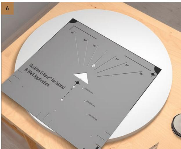
Установите разметочный шаблон таким образом, чтобы линии, прочерченные на шаге 5 вокруг основания треугольника разметочного шаблона, максимально соответствовали ромбовидному вырезу. См. 6 - Подробная информация.
