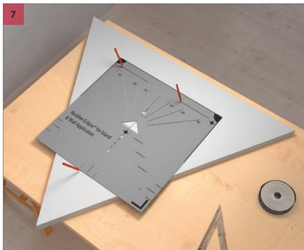
Отметьте линию, по которой следует установить скобу-держатель и положение регулирующего упора, обеспечивающего нужное расстояние. См. 7 - Результат.
