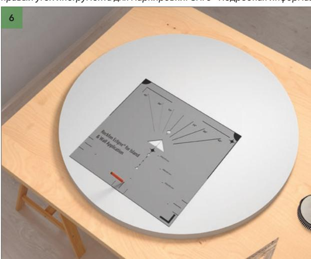
Установите разметочный шаблон таким образом, чтобы центральные линии, прочерченные на шаге 5, максимально соответствовали точке в основании треугольника на разметочном шаблоне и отметьте положение регулирующего упора, обеспечивающего зазор. См. 6 – Подробная информация.
