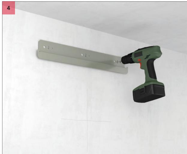
Просверлите отверстия и установите кронштейн для установки.
