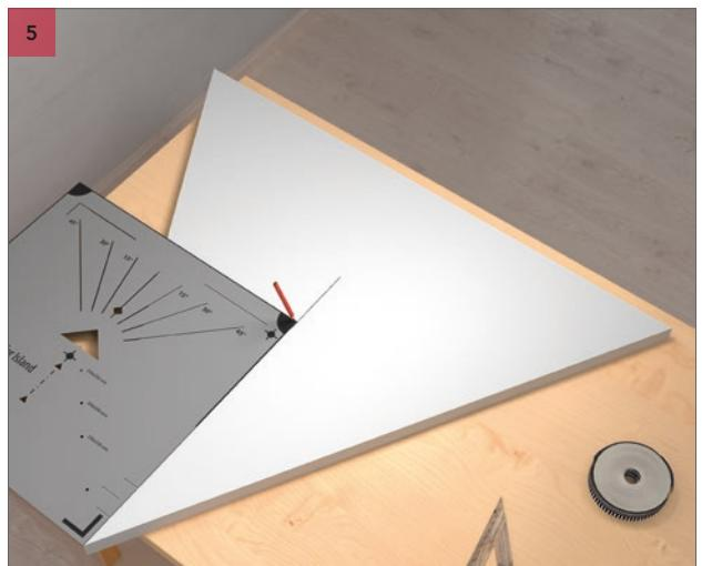
Установите разметочный шаблон в нижний угол с задней стороны стенной панели Rockfon Eclipse и отметьте карандашом центральные линии, используя угол разметочного шаблона. См. 5 - Результат.
