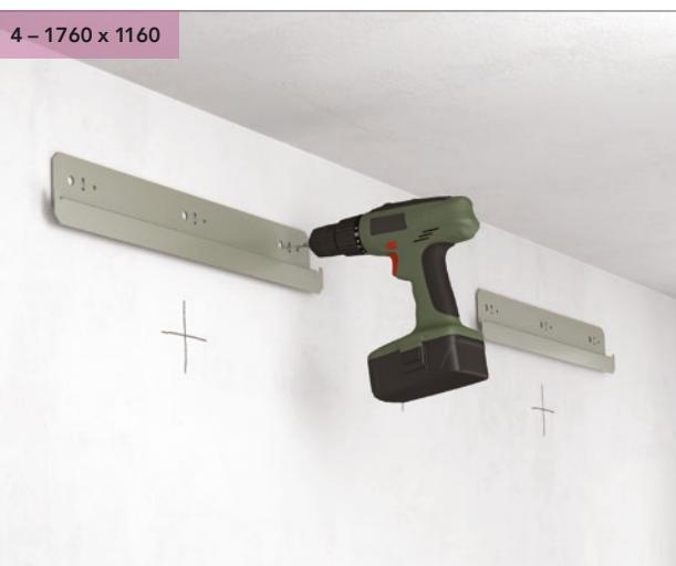
Просверлите отверстия и установите кронштейн для установки.
