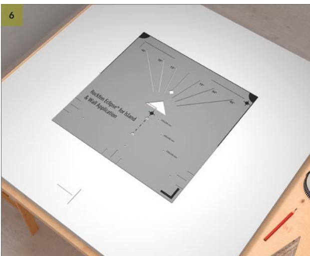
Установите разметочный шаблон таким образом, чтобы центральные линии, прочерченные на шаге 5, максимально соответствовали точке в основании треугольника на разметочном шаблоне. См. 6 - Подробная информация.
