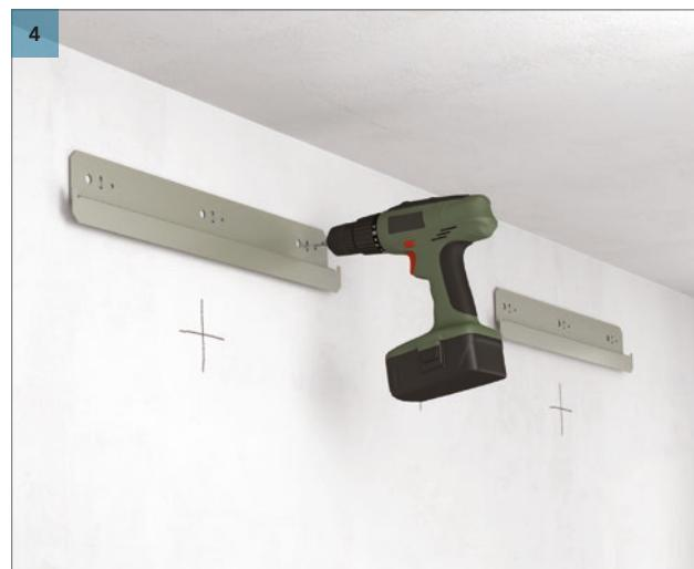
Просверлите отверстия и установите кронштейн для установки.
