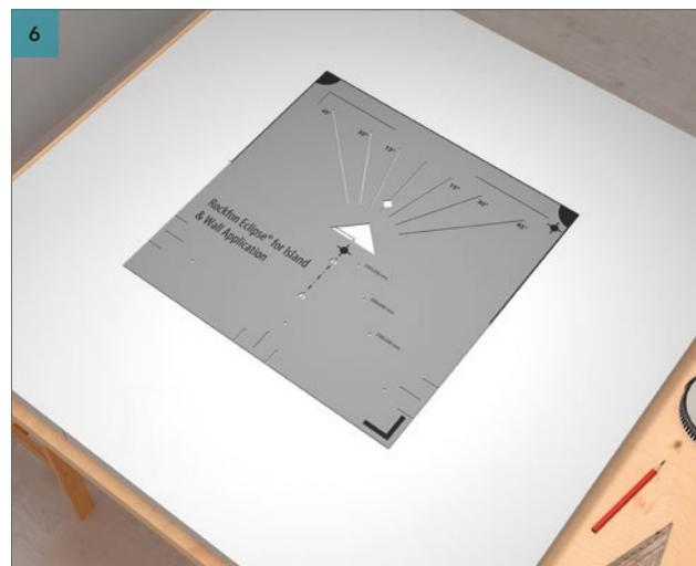
Установите разметочный шаблон таким образом, чтобы центральные линии, прочерченные на шаге 5, максимально соответствовали точке в основании треугольника на разметочном инструменте. См. 6 – Подробная информация.
