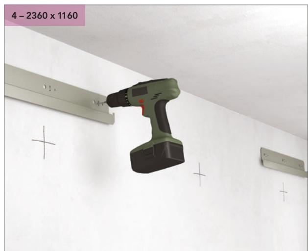
Просверлите отверстия и установите кронштейн для установки.
