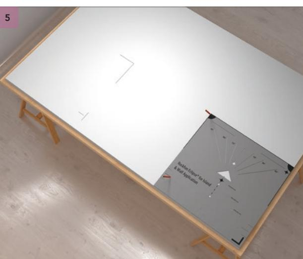
Установите разметочный шаблон в нижний правый угол с задней стороны стеновой панели Rockfon Eclipse. Отметьте карандашом центральные линии, используя левый верхний угол разметочного шаблона, и положение регулирующего упора, обеспечивающего нужное расстояние.
