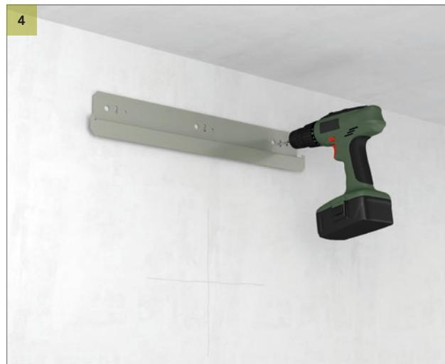
Просверлите отверстия и установите кронштейн для установки.
