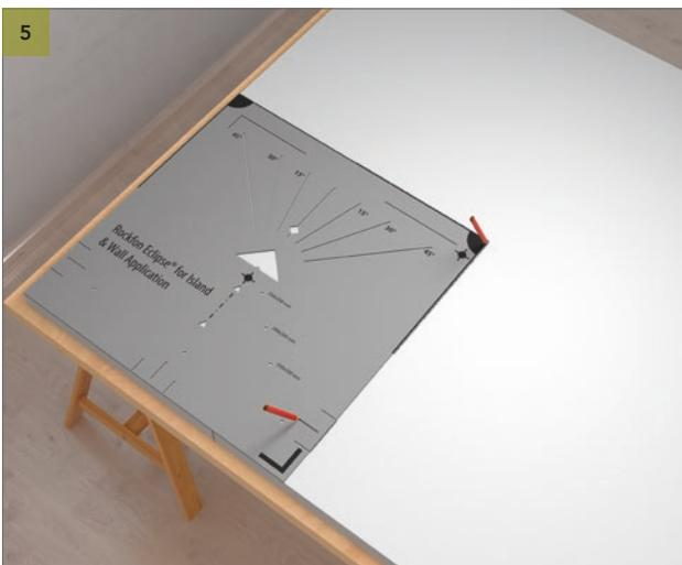
Установите разметочный шаблон в нижний левый угол с задней стороны стенной панели Rockfon Eclipse. Отметьте карандашом центральные линии, используя угол разметочного шаблона, и положение регулирующего упора, обеспечивающего нужное расстояние. См. 5 - Результат.
