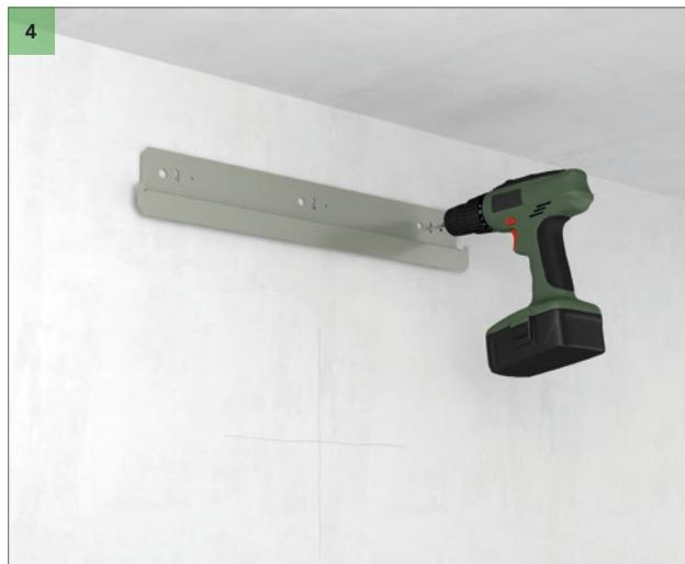
Просверлите отверстия и установите кронштейн для установки.
