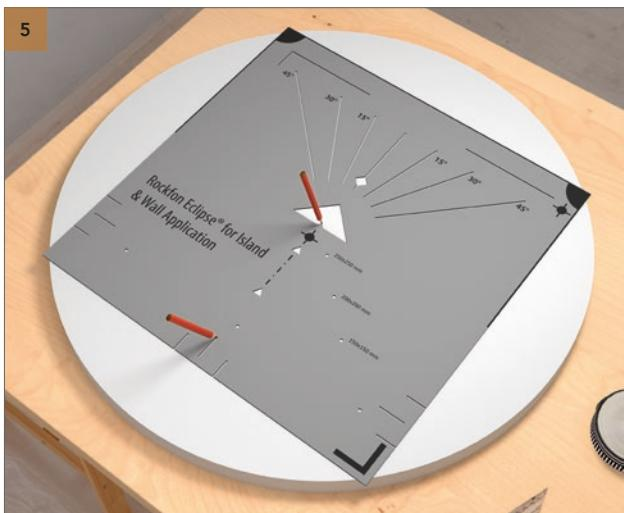
Установите разметочный шаблон с задней стороны стеновой панели и отметьте карандашом основание треугольника и положение регулирующего упора, обеспечивающего зазор. См. 5 - Результат.
